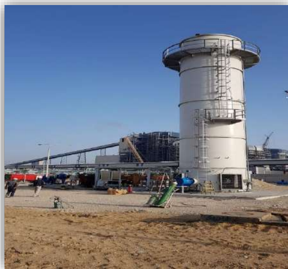
תמונה מס' 1 – מערכת VCU בקצא"א למישוב אדי הדלק והפחתת פליטות בנזן ומטרדי ריחות
